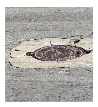
**JUSTIFICAMOS** o pedido tendo em vista a necessidade de manutenção na galeria de acesso do Semasa, pois conforme se observa, existem rachaduras e afundamento da via, o que vem causando acidentes e danos nos veículos.
