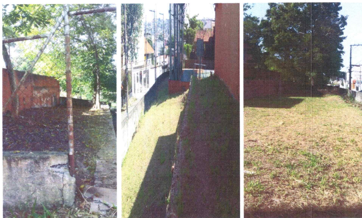
Fotos do serviço executado em 06/03/2024
