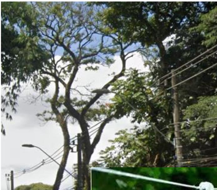
**Rede “spacer cable”:** é a substituição da rede de média tensão mais antiga feita com cabos nus para uma rede mais moderna, com cabos protegidos. Este tipo de rede tem menos desligamentos por toque de galho de árvores em razão da sua cobertura (obs.: não é isolamento).
