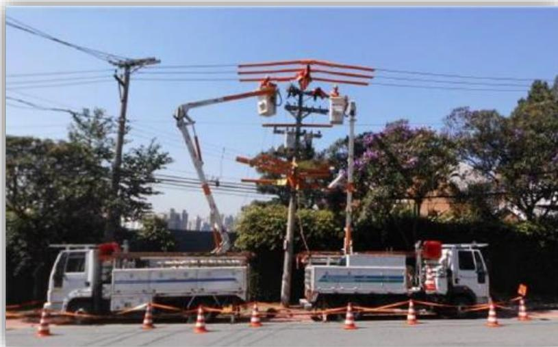
**Manutenção Preventiva** é composta de troca de equipamentos que estão com a vida útil chegando ao seu limite e componentes da rede que visualmente necessitam de troca.
