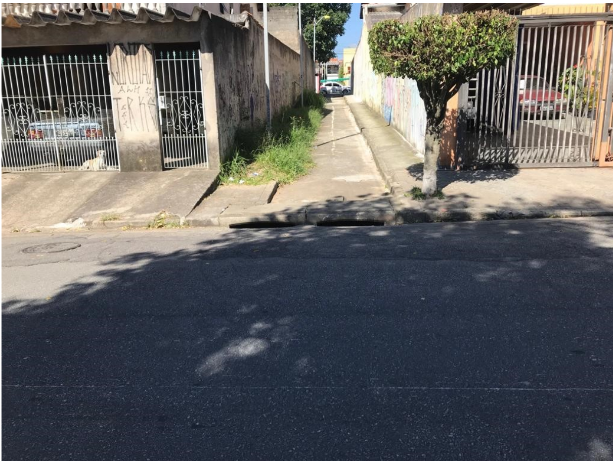
Faixa de pedestre na Rua Benedito Montenegro, em frente ao nº 106
