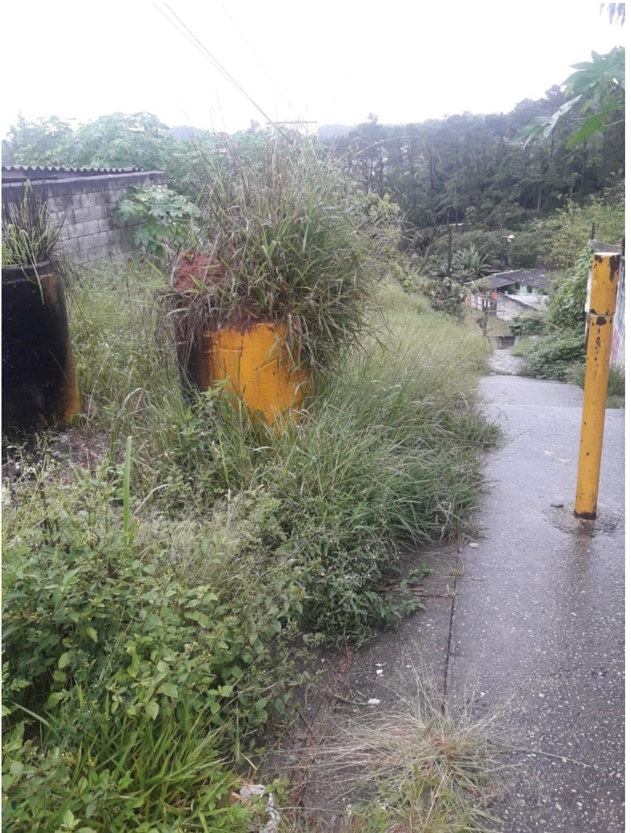
escadão que liga a Rua Rio Ampari à Rua Rio Oiapoque – Parque Miami
