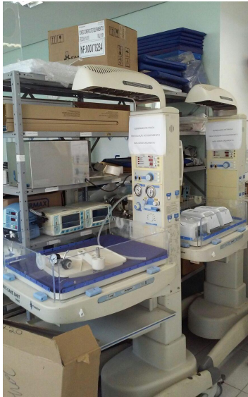
Equipamentos aguardando manutenção
