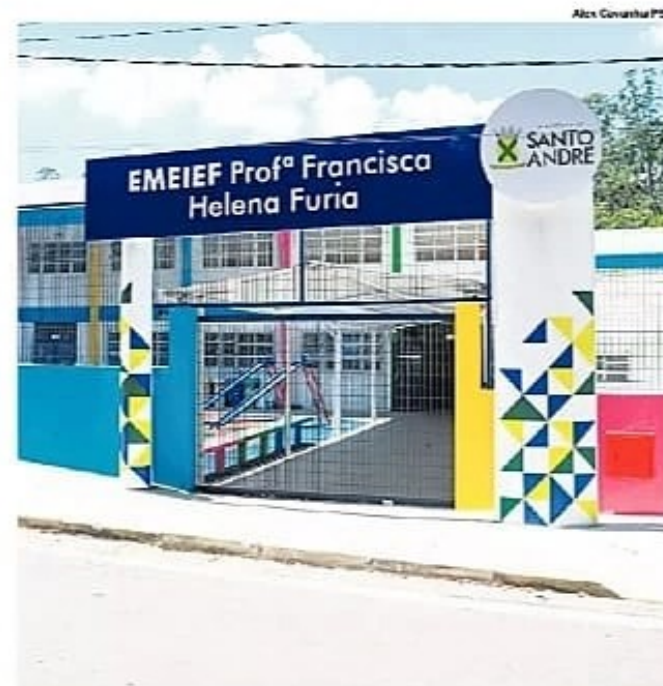
REFORMA. Emeief recebeu pintura, hidráulica, gradis e pisos novos
