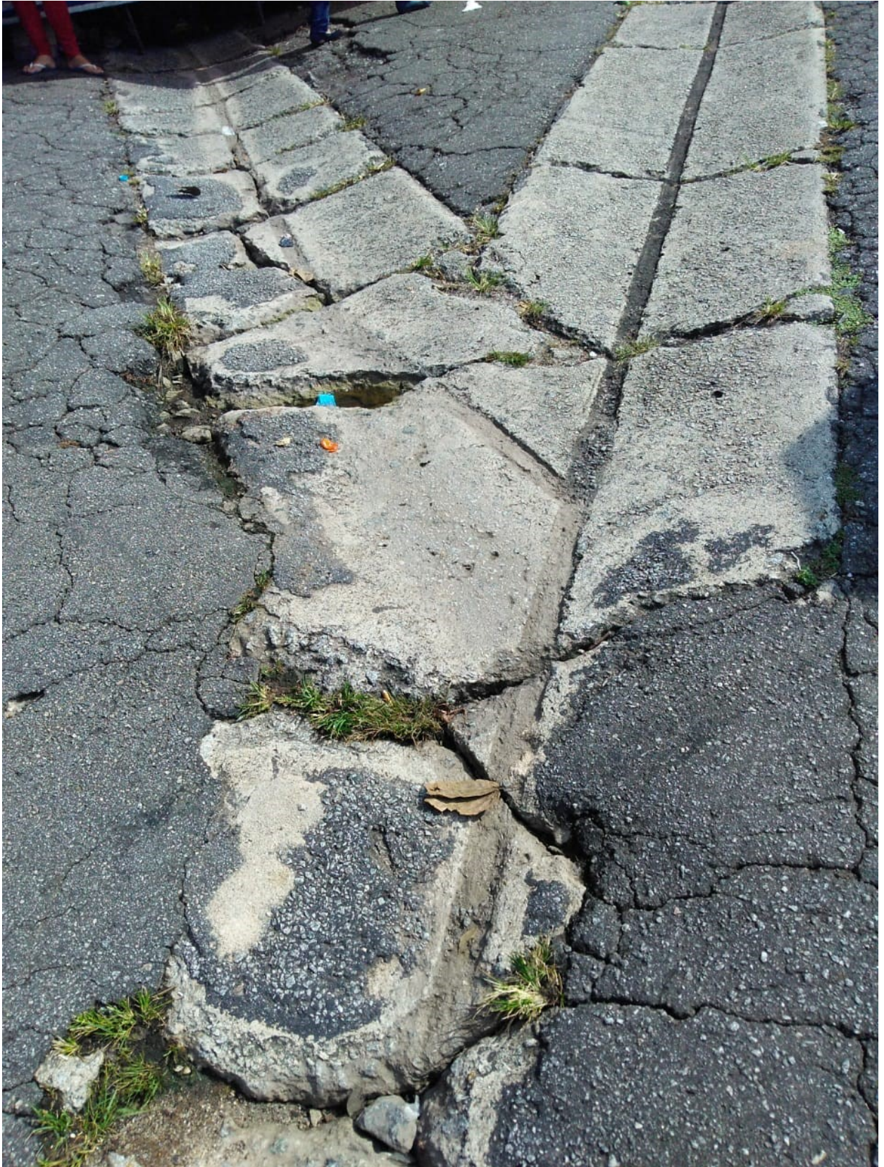
Rua Bauru - Tapar Buracos
