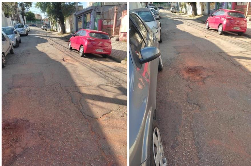
**JUSTIFICAMOS** o pedido tendo em vista a existência de vários buracos, rachaduras e desnivelamento na via pública, causando danos nos veículos e acidentes no local.
