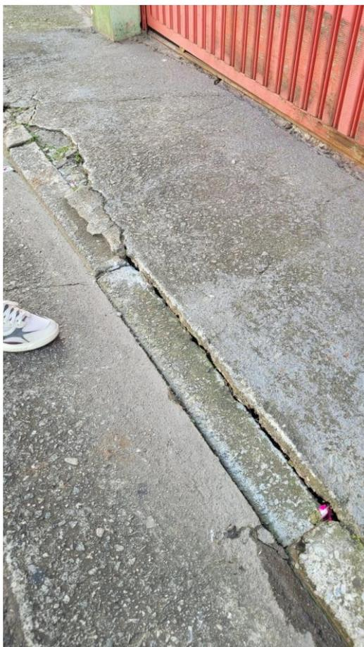
**JUSTIFICAMOS** o pedido tendo em vista a solicitação do morador que alega que no local existe um vazamento de água no meio fio da rua, o solo está cedendo e causando danos no imóvel, bem como pode ocorrer uma cidente com o afundamento da rua.
