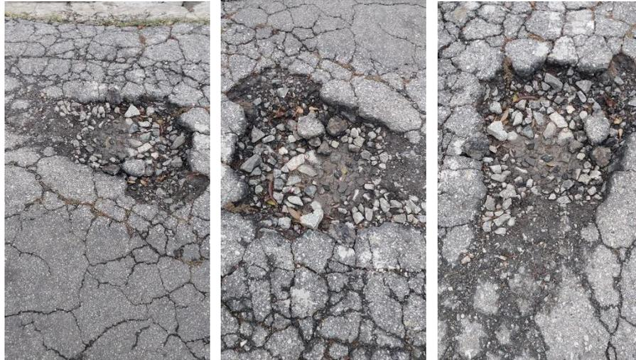
**JUSTIFICAMOS** a presente propositura com base em relatos de munícipes, que apontam o estado precário da pavimentação da referida via, repleta de desníveis, pedras soltas e pontos de erosão, comprometendo a circulação segura de motoristas, ciclistas e pedestres que utilizam a via diariamente;
