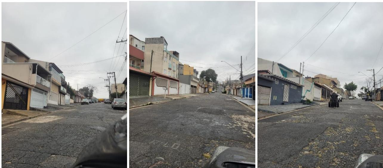
**SOLICITAMOS** a pedido dos moradores a substituição da malha viária da via indicada devido à presença de inúmeros remendos e tapa-buracos, os quais deixaram a via desnivelada e em péssimo estado. Além disso, as condições do asfalto encontram-se deterioradas a ponto de não suportar mais reparos, devendo ser realizada a substituição total da malha viária.
