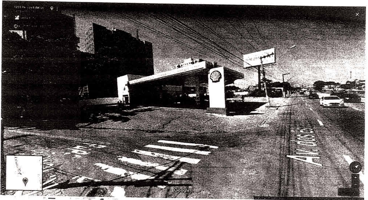
Detalhe da Avenida dos Estados – trecho da área pública invadida (parte da frente do posto)
