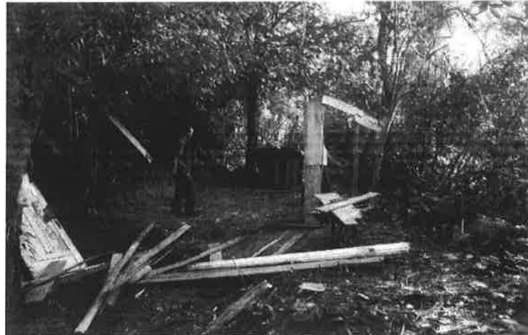
A construção foi demolida e os materiais recolhidos
