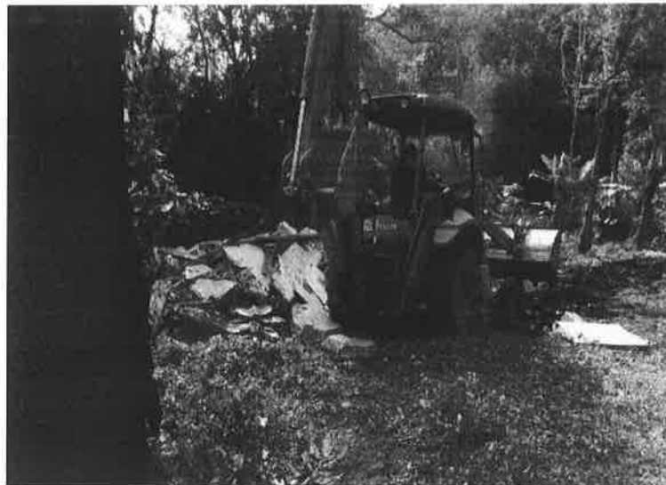
Demolição de construção irregular
